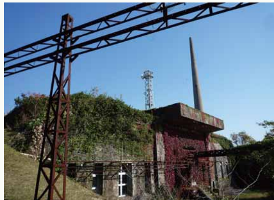
三塔の中心に建つ局舎施設
