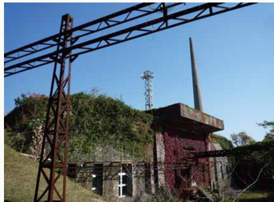
三塔の中心に建つ局舎施設
