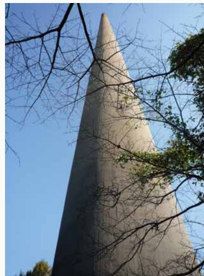
下から見上げた135メートルの巨塔
