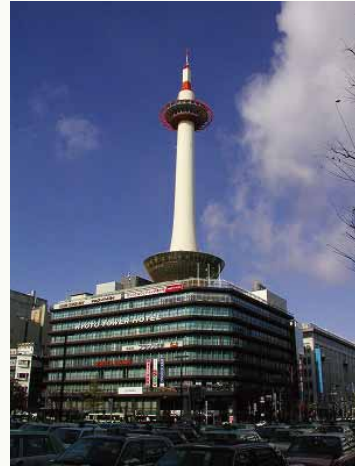
図6 京都タワービル
