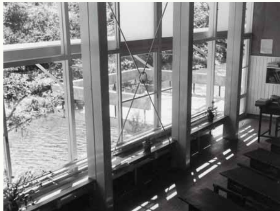
東校舎1階の教室。カーテンウォール形式の外壁の構成がよくわかる（松村家蔵）。
