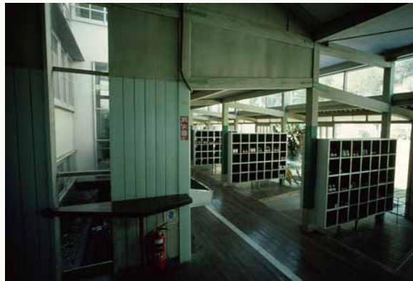
東校舎1階昇降口から教室への前室まわりの様子（撮影：花田佳明）。透明感溢れる構成である。
